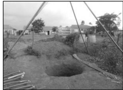
Der neue Brunnen wird gerade fertiggestellt und ist ca. 15 Meter tief (auf dem Foto sieht man das ausgehobene Brunnenloch) und liefert damit zuverlässig Wasser für die notwendige Bewässerung der Maisfelder. Bei der Errichtung konnte bereits in ca. 6 Metern Tiefe
